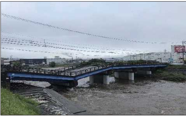
令和3年7月 沼津市黄瀬川大橋
